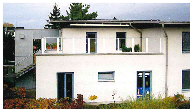
Unser aktuelles Spendenprojekt: eine Dachterrasse am Obergeschoss des Bodelschwinghauses
