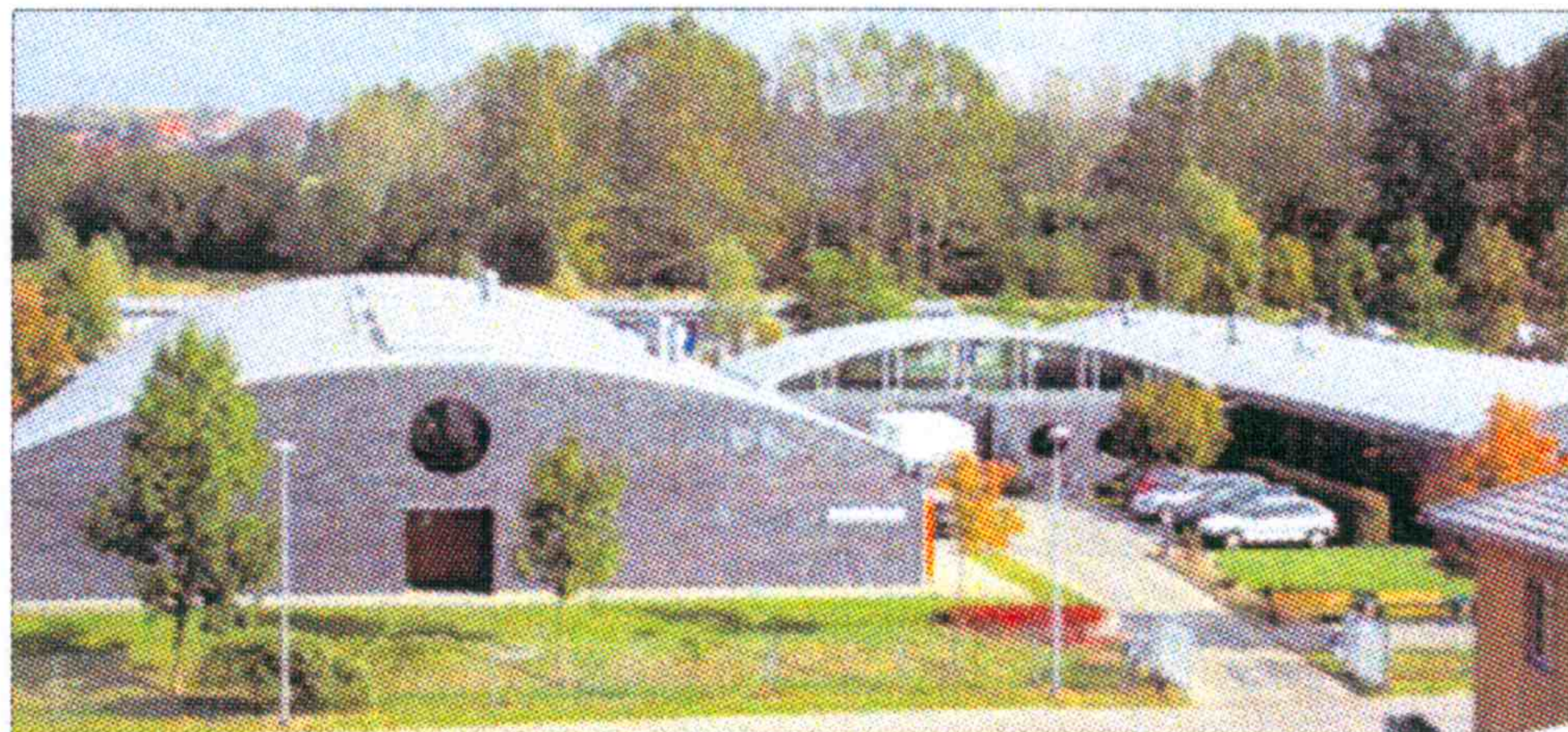
Blick auf die 1998 erbauten Kröpeliner Werkstätten.
