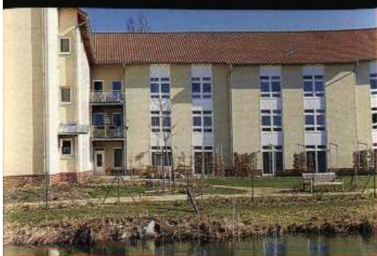
Abbehaus wurde 1996 erbaut.
