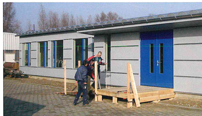
Der Erweiterungsbau der Kröpeliner Werkstätten kurz vor der Fertigstellung
