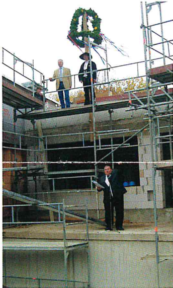
Alle Anwesenden beim Richtfest warten auf das Einschlagen des symbolischen Nagels und den Richtspruch
