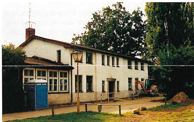
Das alte Bodelschwinghhaus – nach jahrzehntelanger Nutzung wurde es im Oktober 2003 abgerissen.
