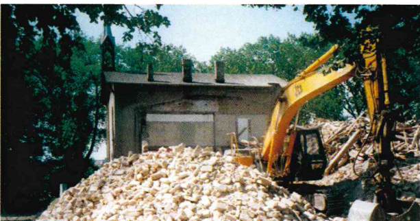
Die alte Substanz des Karstenhauses wurde mittels heutiger Technik in wenigen Tagen abgerissen und entsorgt.
