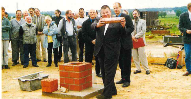
Die Schatulle ist gefüllt und wird eingemauert (Grundsteinlegung WfB Kröpelin am 31. Juli 1998)
