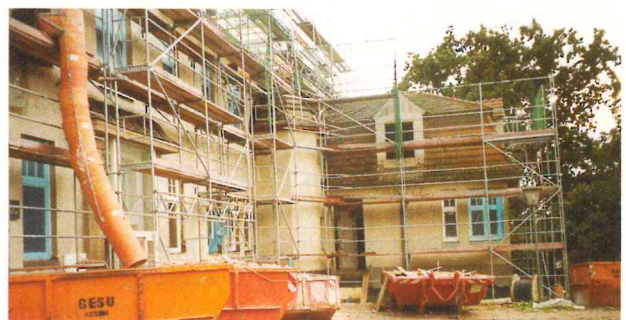
Lärm und Staub während des Bauens sind lästig, aber leider unvermeidlich. (Wichernhaus Sommer 1998)
