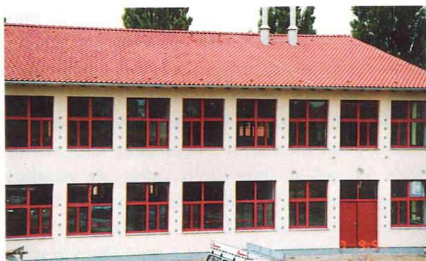
WERKSTATTNEUBAU Architekt: Dannien, Fendrich + Partner
